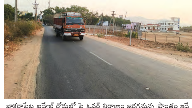
భాకరాపేట బడ్యేల్ రోడ్డులో పై టవర్ నిర్మాణం జరగనున్న ప్రాంతం ఇదే
